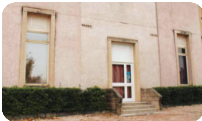
► Remplacement de la porte d'entrée
