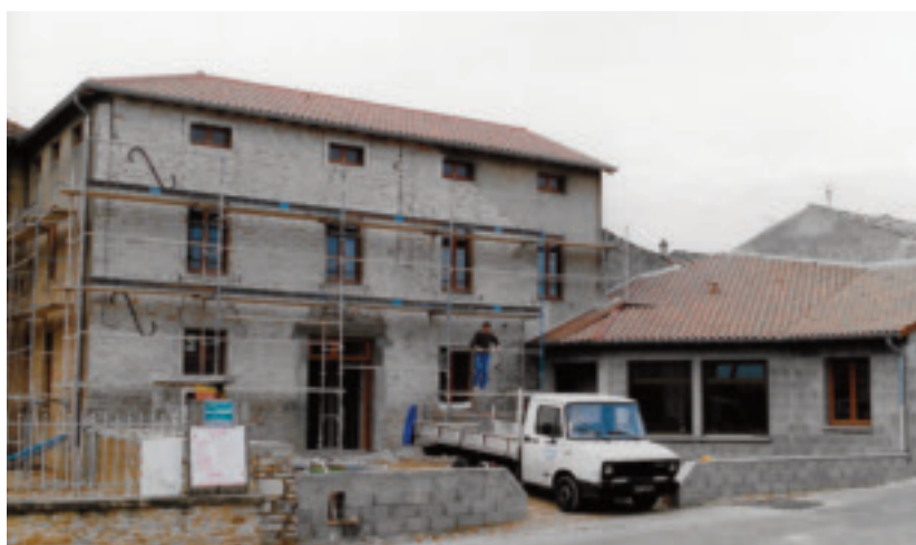
Réfection de façade du bâtiment existant
