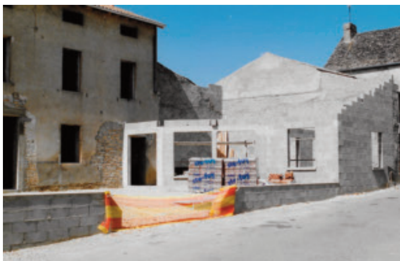
Construction du nouveau bâtiment et des murets
