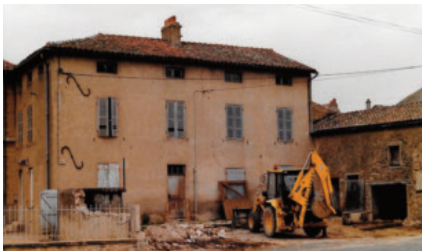
Démolition de la grange
